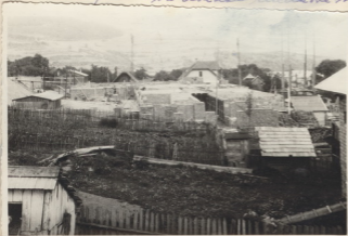
Stavba šk. domu:
